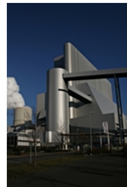
Bloc de centrale thermique au charbon moderne (© Foto: tz/pr)
